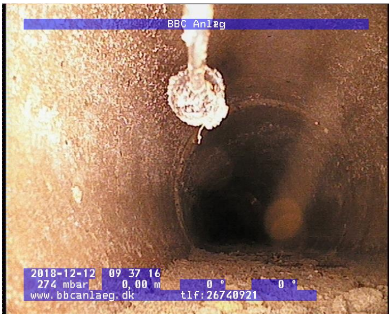
Bar. Margrethes Vej 1; Betonbrønd Ø 60 cm. Drænrør på grund mod vest og med bundgrus/jord.
