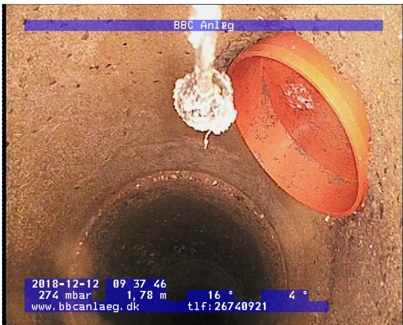
Bar. Margrethes Vej 1; Betonbrønd Ø 60 cm. Drænrør med siderør 1,78 m fra brønd på grund mod vest og med bundgrus/jord.
